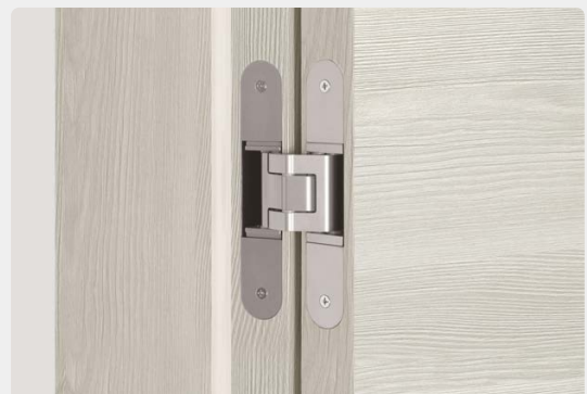
Das verdeckt liegende Band ist bei stumpfen Türen die erste Wahl, da es bei geschlossener Tür nicht sichtbar ist.
