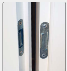
Bandseitensicherung
